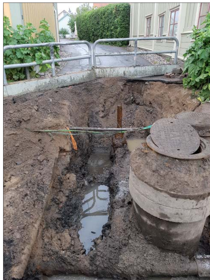
Figur 5. Schakt 2. Foto från sydöst, Helén Romedahl, ÖM.
