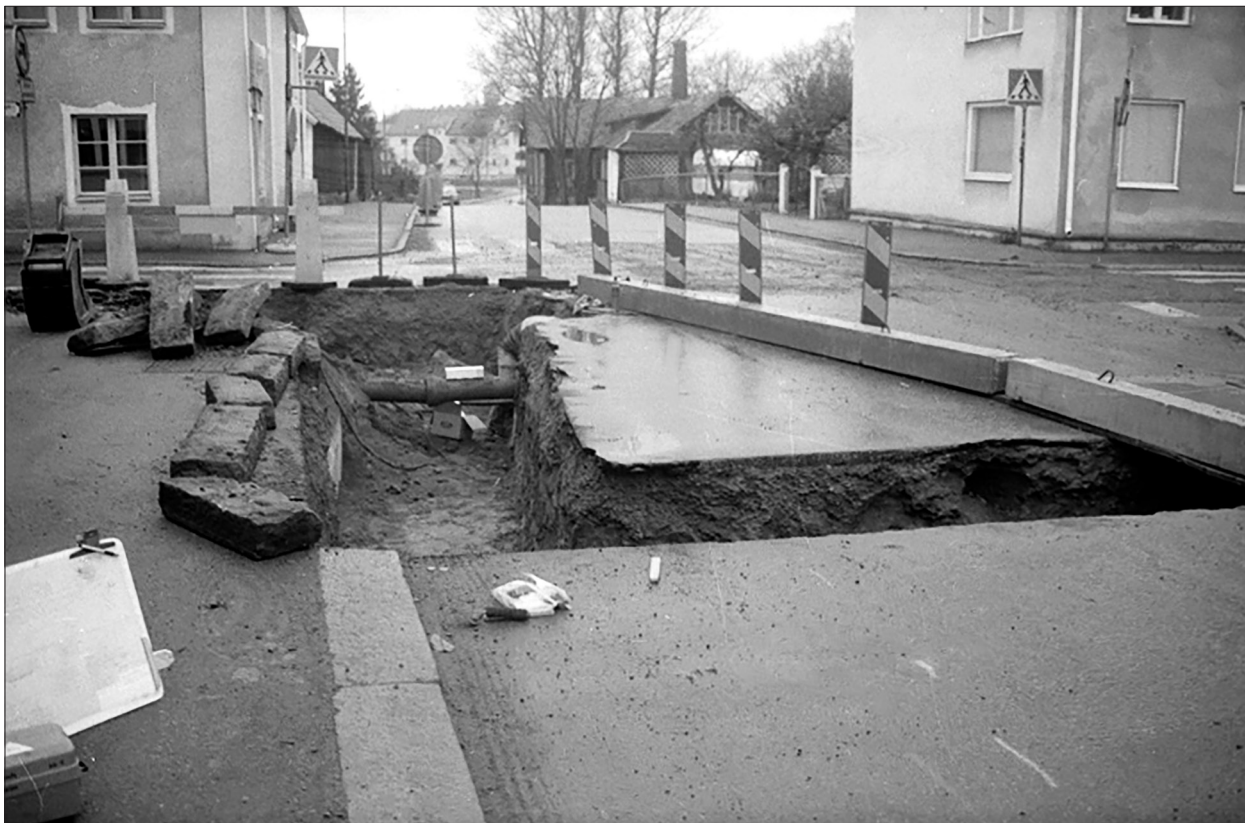
Figur 5. Schakt 1 och 2 i korsningen Borggatan – Follingegatan sett från öster. Foto Ann-Charlott Feldt, ÖM.
