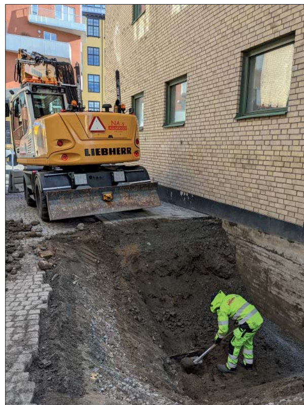
Figur 7. Schaktning pågår i Schakt 1. Foto mot NÖ, Linnéa Hernqvist, ÖM.
