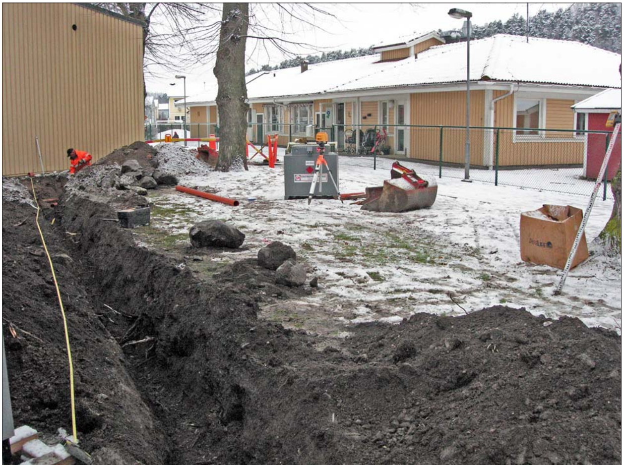
Figur 4. Schaktet sett från sydöst. Foto Emma Karlsson, ÖM.
