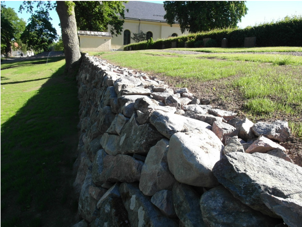
Omlagd mur från söder.
