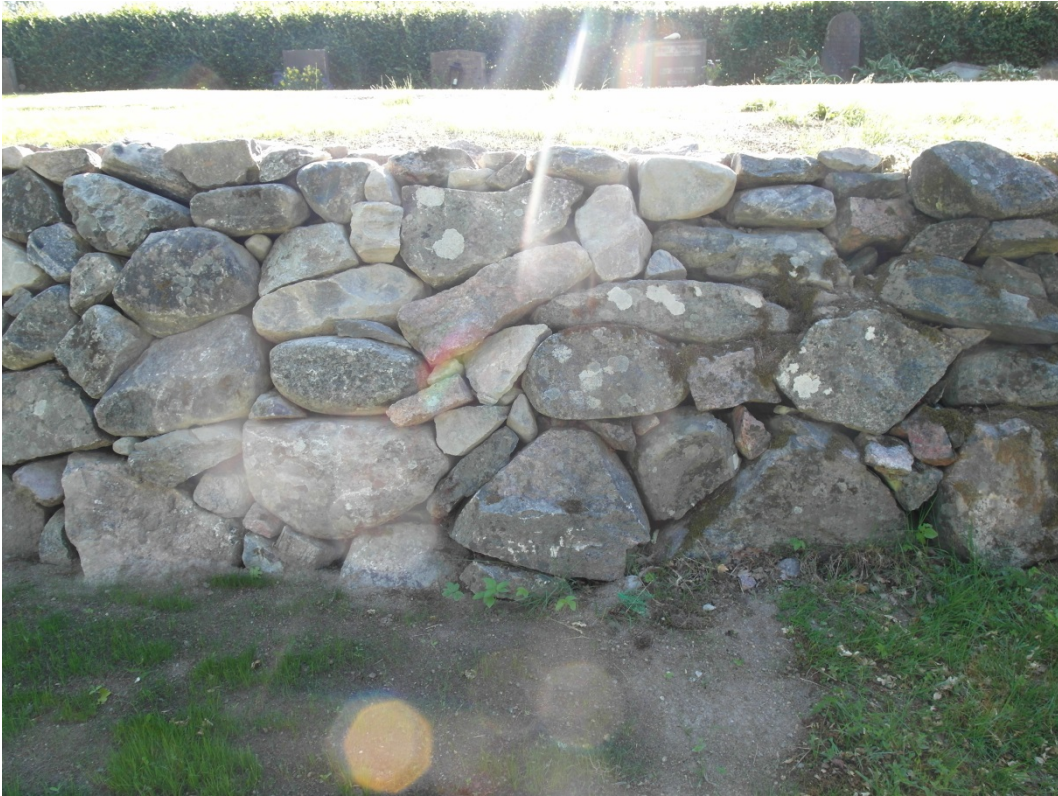
Skarv mellan omlagt parti och orörd mur.
