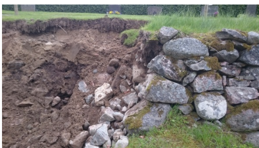
Själva muren är ca 0,5 m djup. Foto Markmästarna.
