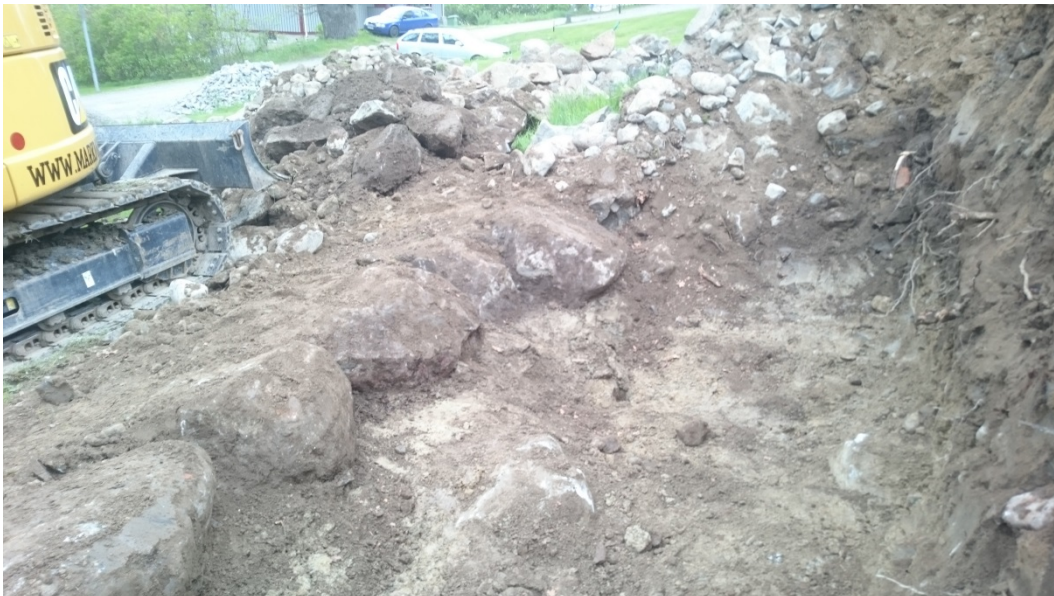
Marken har grävts ur till murens botten. Foto Markmästarna.
