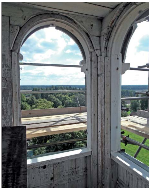
Lanterninfönstren plockades ur för renovering och ommålning. Foto Östergötlands museum 2013.
