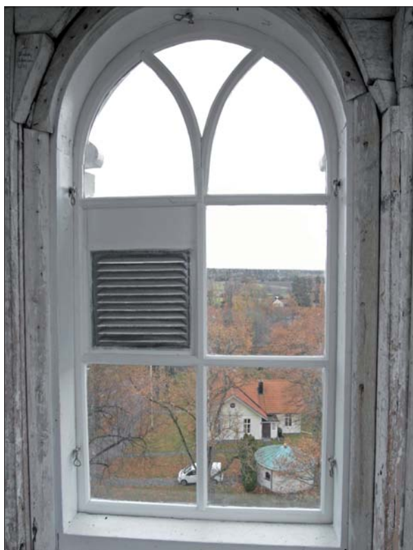
Fönstren är återigen på plats. Det fanns sedan tidigare ventiler i fyra av fönstren. Foto Östergötlands museum 2013.
