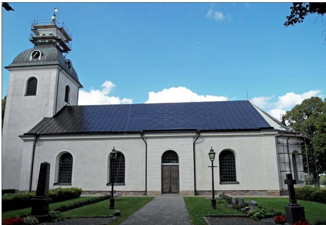
Södra långhustaket är färdigmålat. Foto Östergötlands museum 2013.
