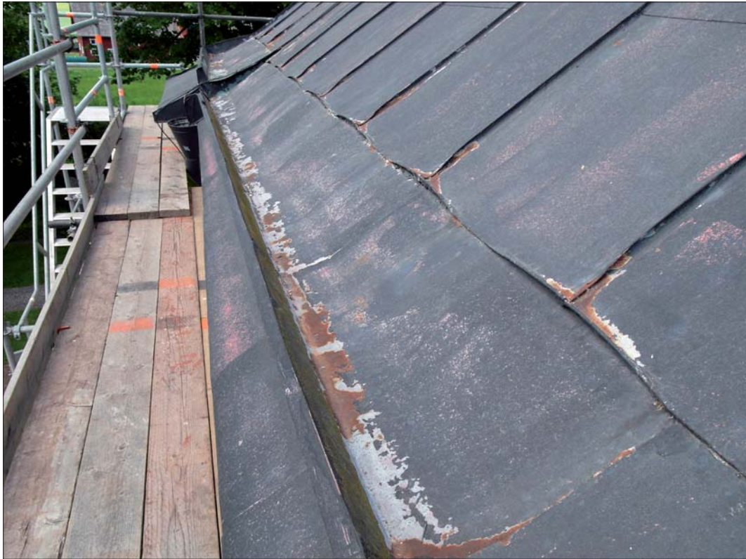
Västra delen på långhusets södra takfall. Foto Östergötlands museum 2013.
