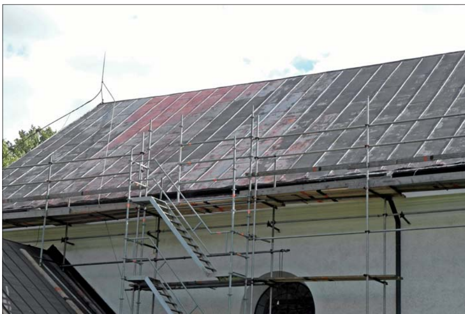
Norra takfallet. Foto Östergötlands museum 2013.
