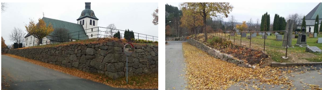
I den nu avslutade etappen av renovering av bogårdsmurar har man satt upp smidesstaket fram till kvarter A/C. Foto Per Johansson, Kisa 2015.
