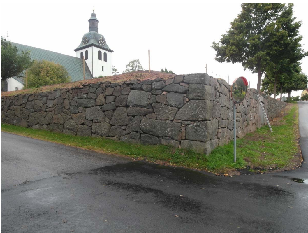
Nordöstra muren efter omläggning.
