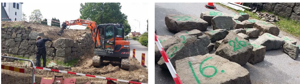
Omläggning av muren. T v: Nordöstra murhörnet läggs om. T h: stenarna numrerades på insidan för att visa platsen i muren. Foto Per Johansson, Kisa 2015.
