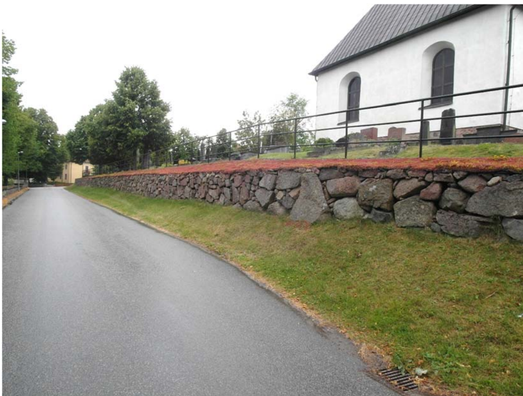
Östra murens södra del har åtgärdats vid ett tidigare tillfälle.
