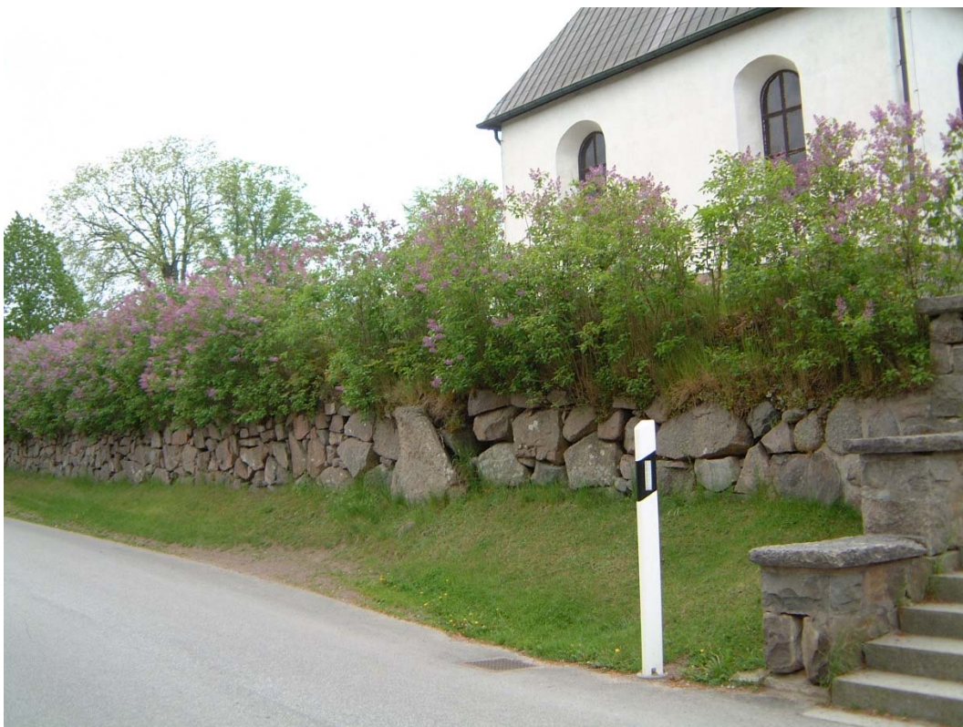
Östra bogårdsmuren med syrenhäck. Denna del av muren åtgärdades vid en tidigare etapp, troligen 2008/2009. Foto Östergötlands museum 2002.
